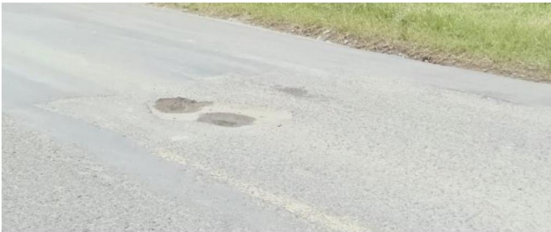
Gambar 2 : Kerusakan Lubang
