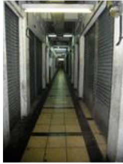
Gambar 3.1. Koridor Pasar Wonokromo Surabaya tidak dilengkapi dengan exhaust untuk menarik udara panas di bawah langit-langit
